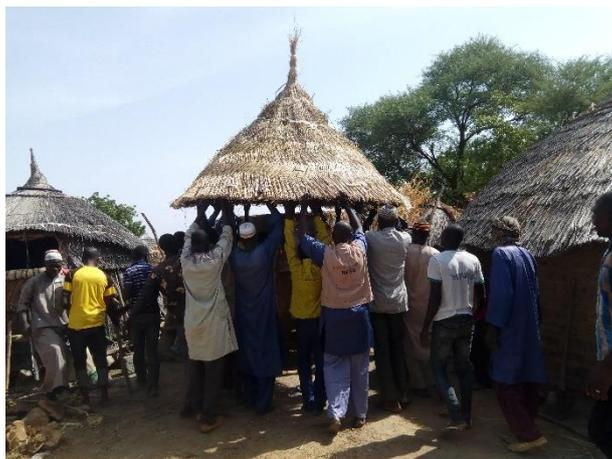
**Photo 25 : Fixation de la toiture**
