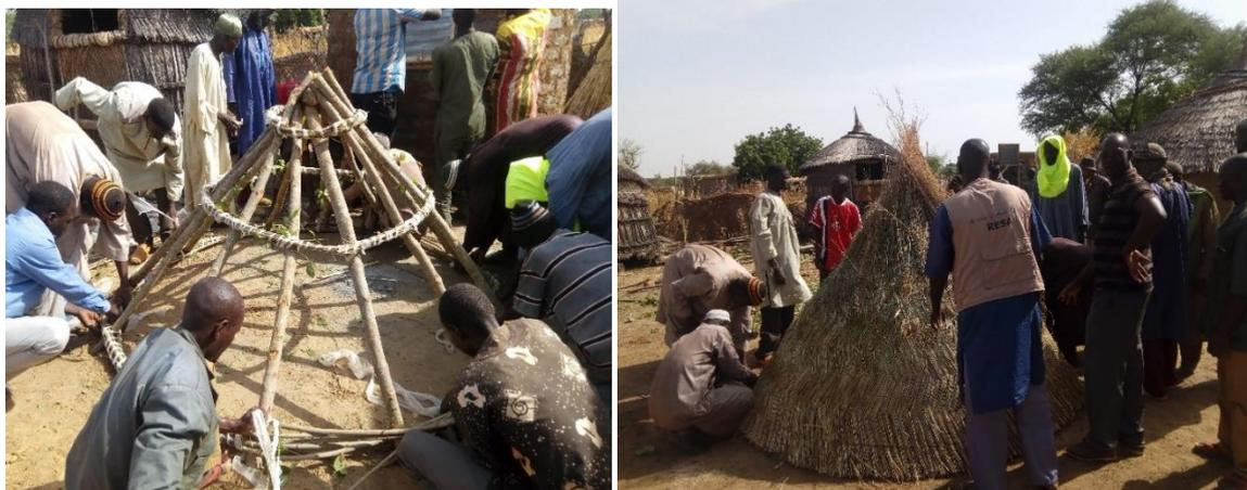
***Photos 24 : Réalisation de la Toiture du grenier***
