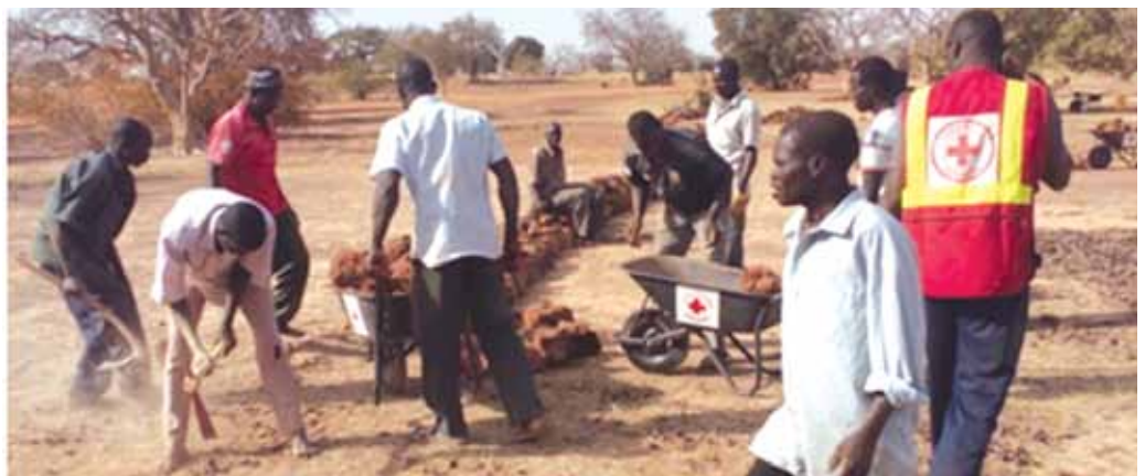
Réalisation de cordons pierreux par les bénéficiaires sous la supervision de l'animateur terrain
